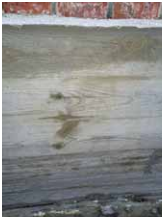
Bild3: Sichtbetonoberfläche mit Texturierung
